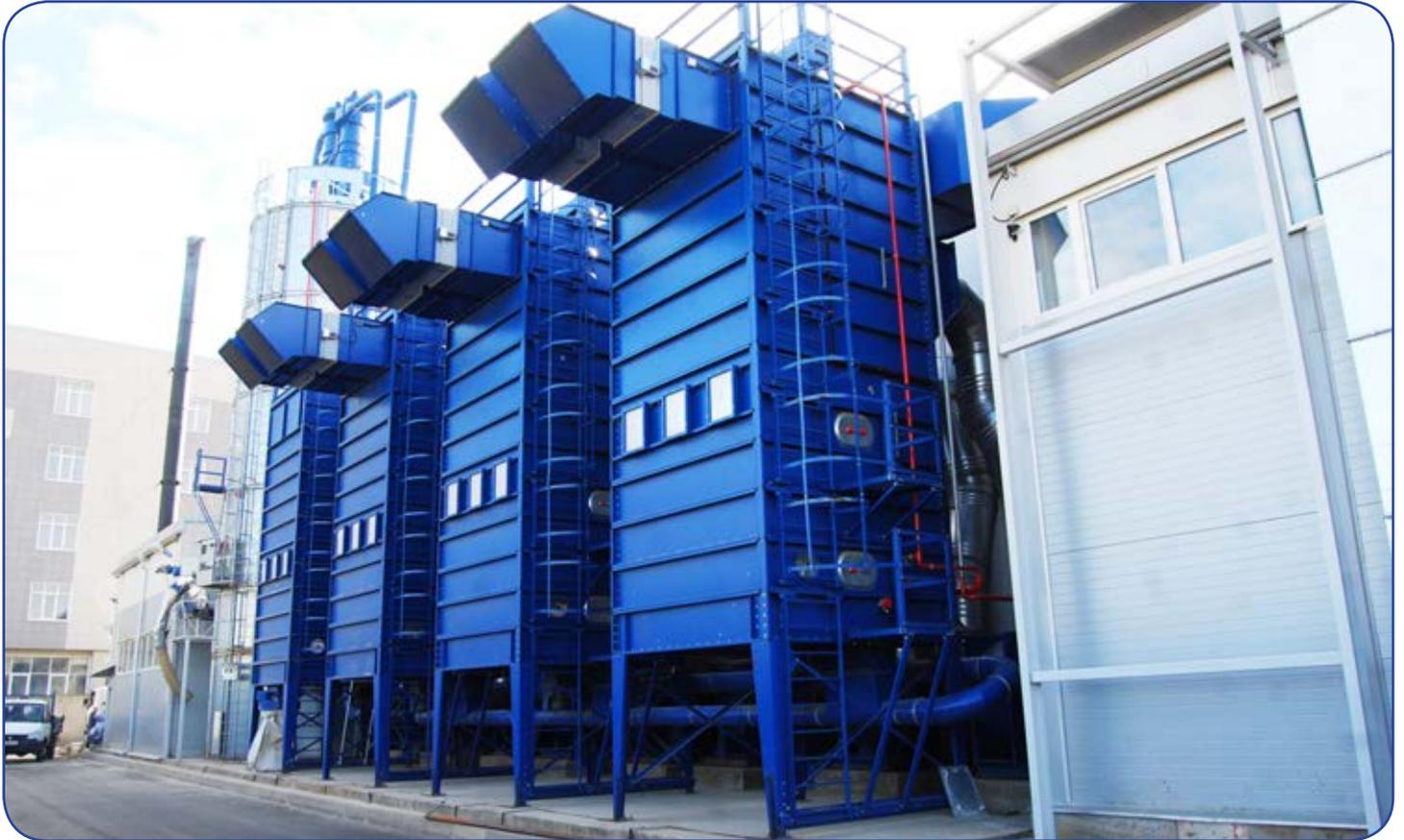
Производство кухонной мебели. г. Люберцы, Московской области. Производство кухонной мебели. Система аспирации общей производительностью 200 000 м<sup>3</sup>/час. Рукавные фильтры с импульсной продувкой ФРИ-50СБ.
