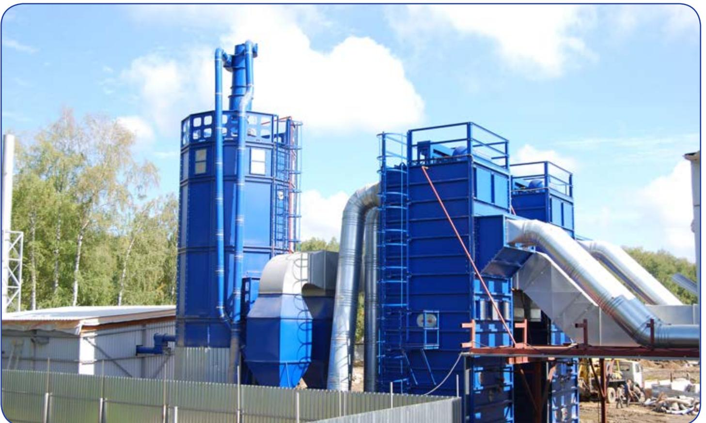
Производство дверей г. Москва, п. Курилово. Система аспирации общей производительностью 100 000 м<sup>3</sup>/час. Рукавные фильтры с импульсной продувкой ФРИ-50СБ. Выгрузка пыли в силос V= 55 м<sup>3</sup>. Выгрузка из силоса в котельную или автомобиль.
