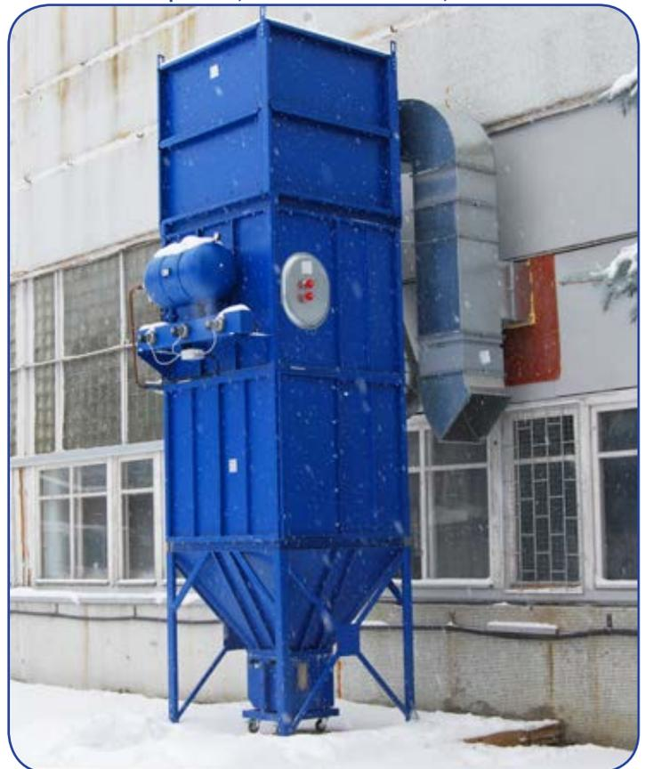
Система аспирации 9 000 м<sup>3</sup>/час. Кассетный фильтр с импульсной
