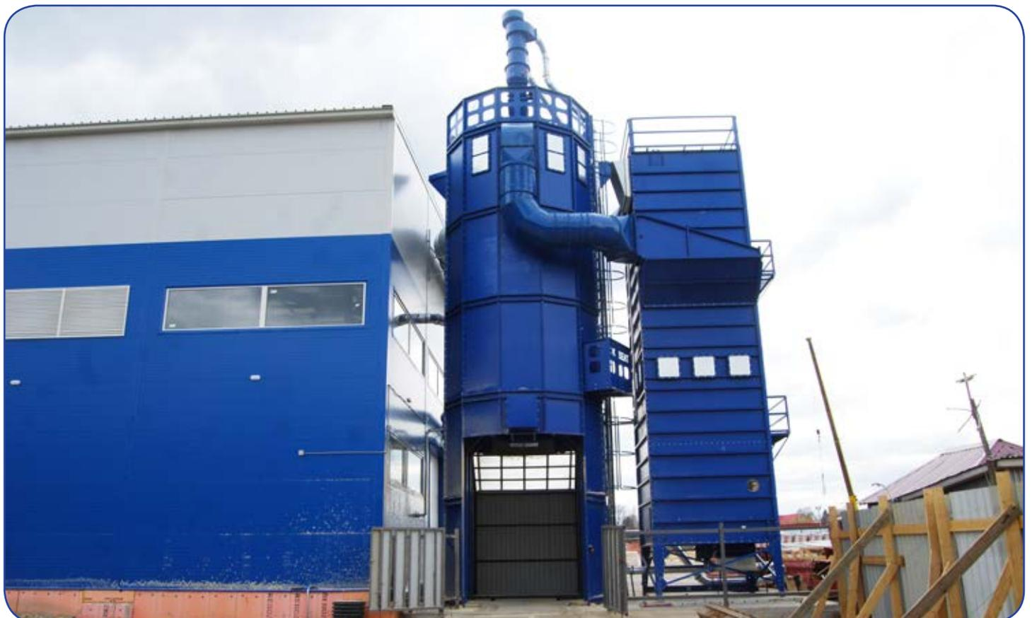
Система аспирации 50 000 м<sup>3</sup>/час. Рукавный фильтр с импульсной продувкой ФРИ-50СБ. Выгрузка пыли в силос V= 55 м<sup>3</sup>. Вентилятор установлен в шумоизолированном корпусе на крышке фильтра. Производство деревянных домов, Московская область, г. Бронницы.
