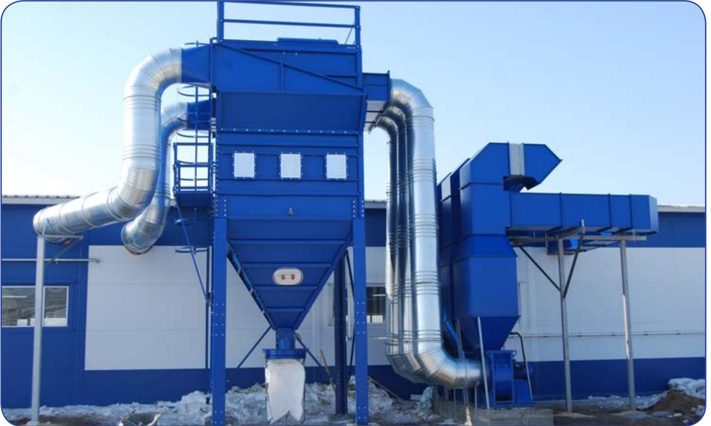
Производство межкомнатных дверей г. Ульяновск. Система аспирации производительностью 60 000 м<sup>3</sup>/час. Кассетный фильтр с импульсной продувкой ФКБ-48СБ.
